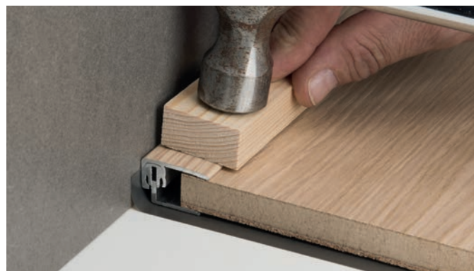
Instalace ukončovacího profilu hliníkového
